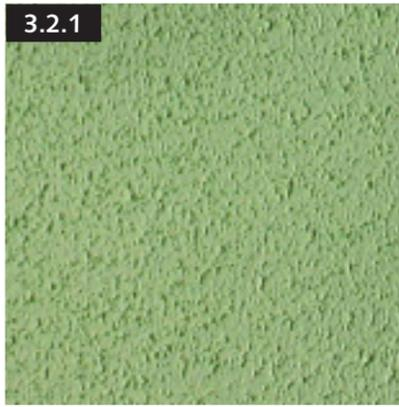
FEIDAL Silicon Streichputz: придание желаемой структуры осуществляется с помощью рельефного или структурного поролонового, мехового валика
