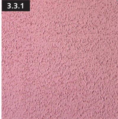
Наносить без разбавления с помощью специального валика крестообразными движениями.
